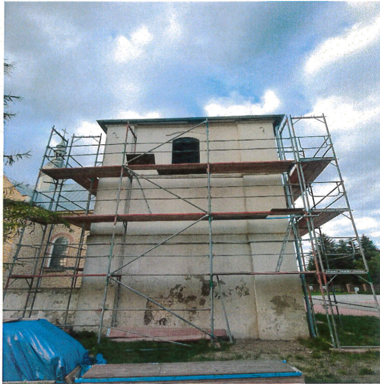
WIDOK ZABUDOWY - ELEWACJI TYLNEJ, OD STRONY POŁUDNIOWEJ BUDYNKU DZWONNICY
