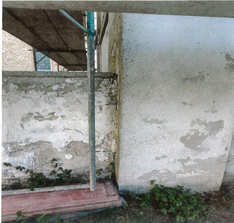
WIDOK ZABUDOWY – Ściany ELEWACJI TYLNEJ, OD STRONY POŁUDNIOWEJ Połączenie muru ogrodzenia z murem budynku dzwonnicy
